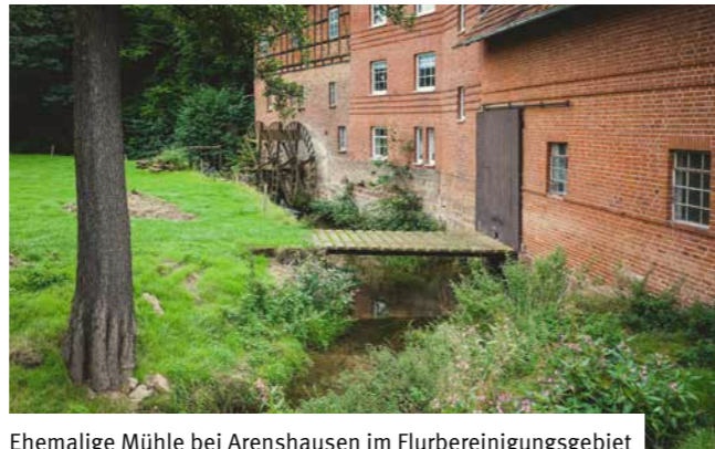
Ehemalige Mühle bei Arenshausen im Flurbereinigungsgebiet
